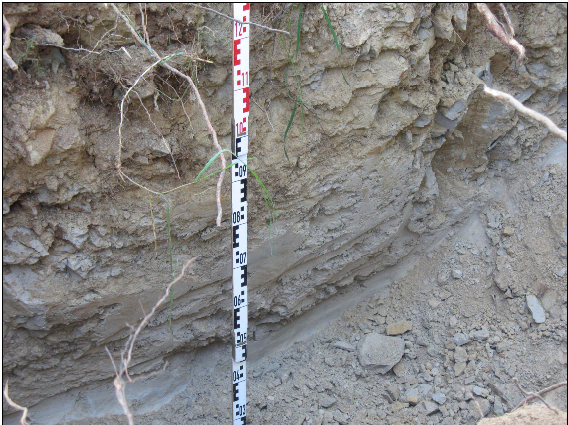
Foto 1: Beobachtungsschurf S 1B: Ausgeprägte feinsandige Dolomit-Zersatzzone bis ca. 0,8-1,3 m u. GOK (Foto: HTR, 26.08.2016)
